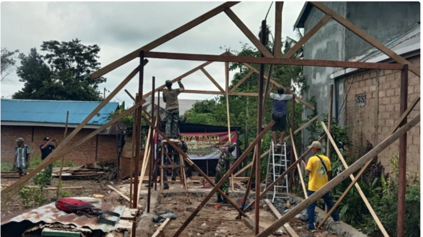
Setelah Dirobohkan " Kini Rumah Nursiah Dipasang Pondasi Dan Kuda - Kuda Rangka Rumah
